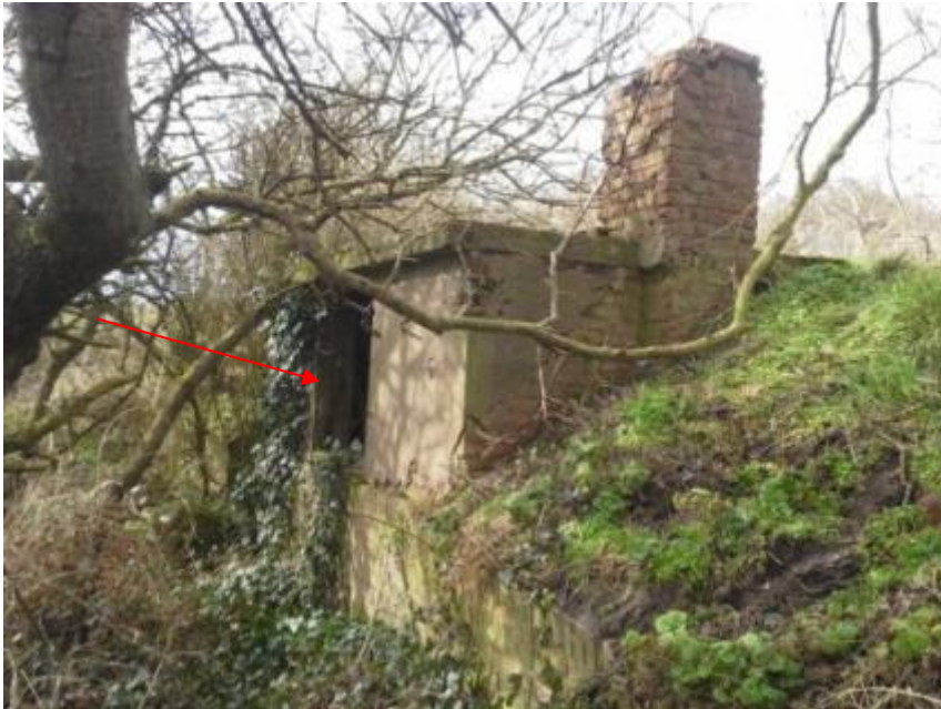
Aanduiding met rode pijl: dicht te maken raam
