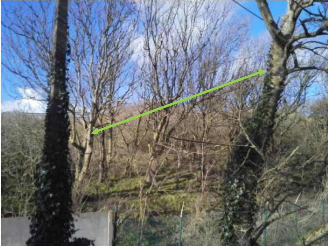
Aanbrengen van stalen kabel over de Duinenweg
